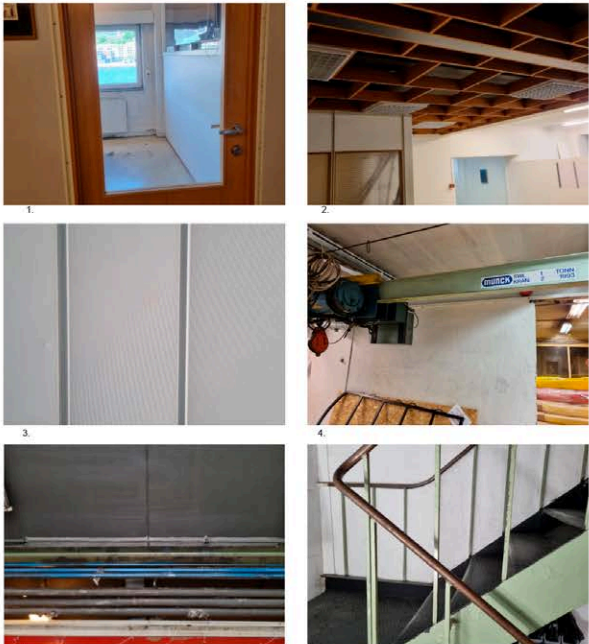
1. Innerdør i tre 2. Himling av furu med lysarmatur 3. Profonerte takplater i aluminium 4. Travorskran 5. Rør 6. Trapp i stål
