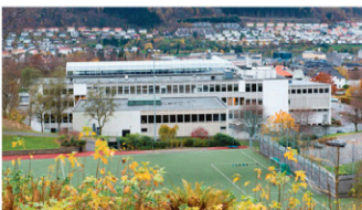
Landåssvingen 15, Tidligere Læringsplazsen på Landås
